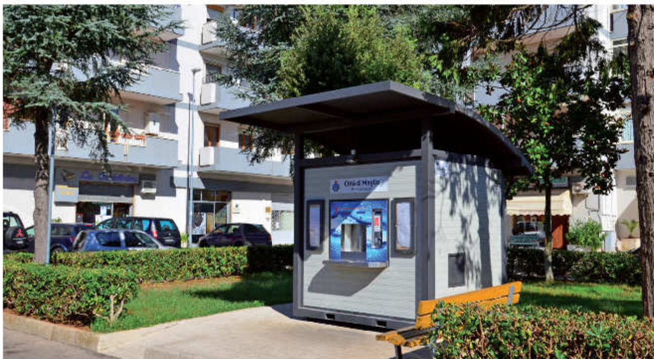
Casa dell'acqua installata a Maglie (Le)
