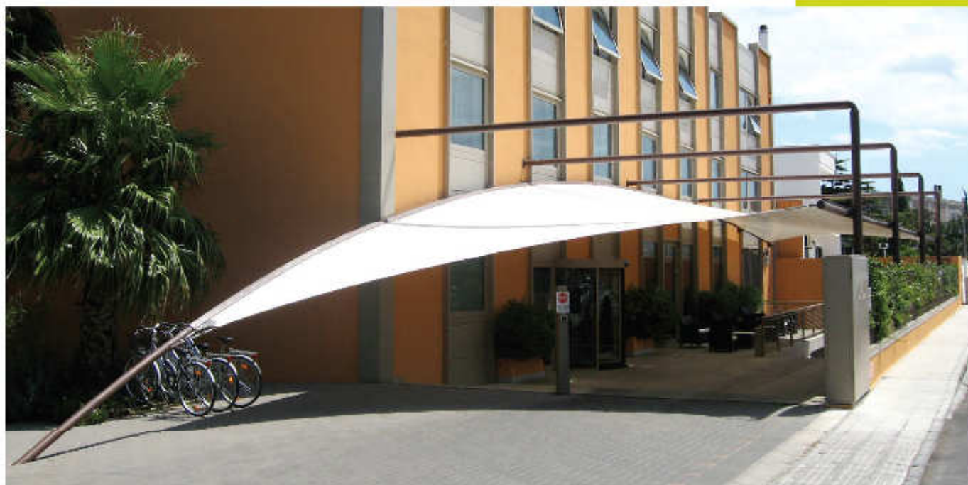
Carpignano Salentino - Le - Sanlu Hotel Tensostruttura
