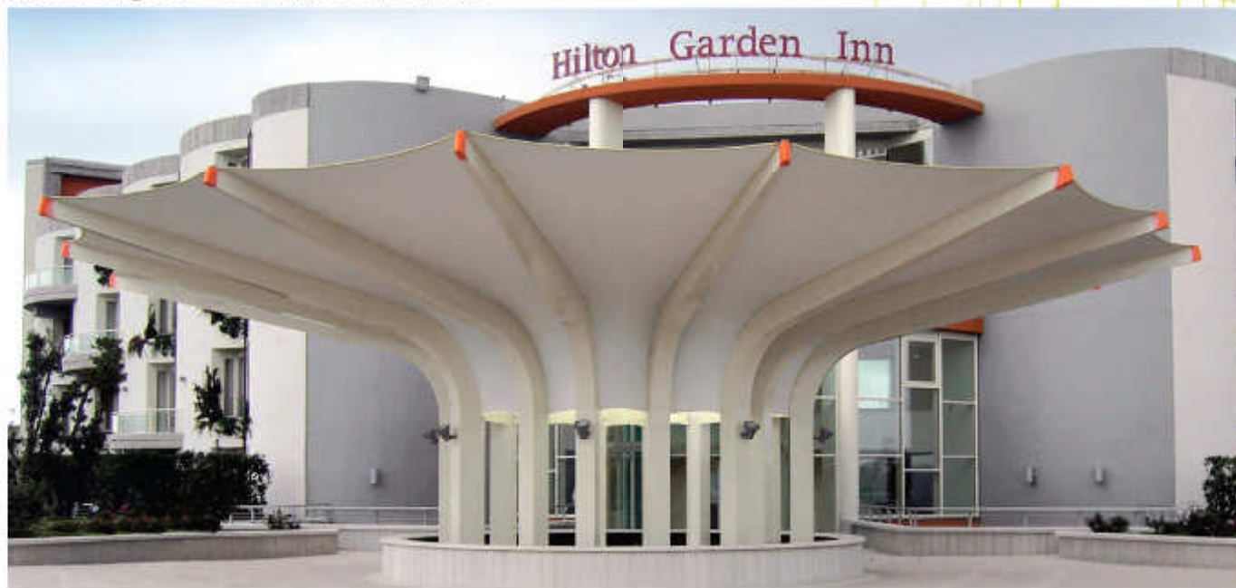
Matera - ingresso Hotel Hilton Garden Inn
