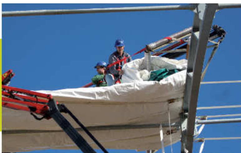
Maglie - LE - Circolo tennis fasi di montaggio
