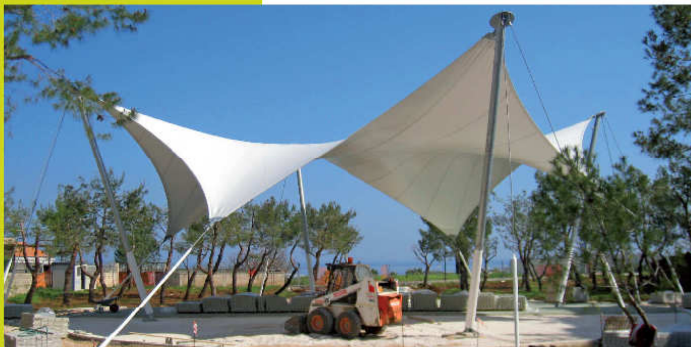
Monopoli - BA Tensostruttura ottagonale diametro m 20
