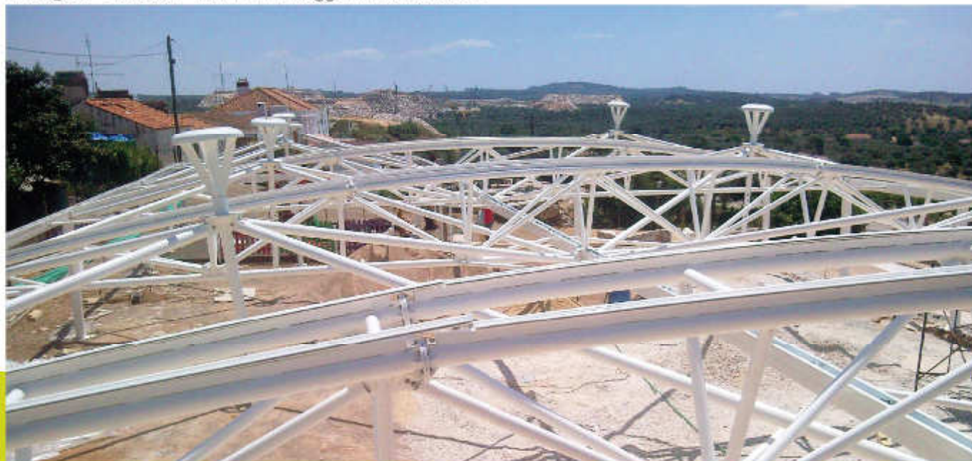
Portogallo - Cascais - fasi di montaggio della struttura
